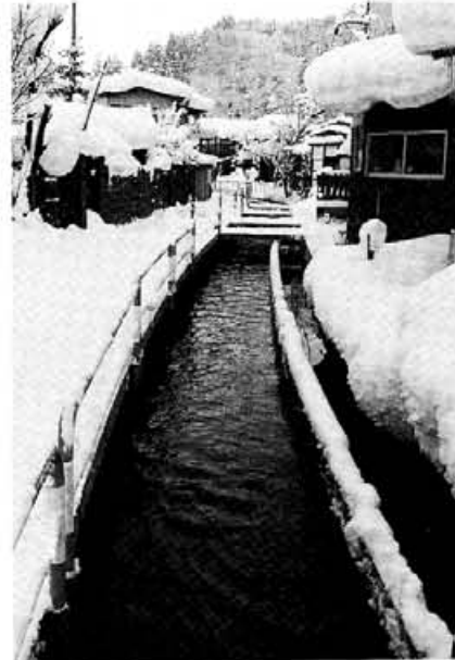
5-1-3 市街地を流れる「大堰」(秋田県・湯沢市)
