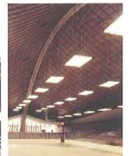
1本アーチの安定化のための補強ケーブルが見える。
