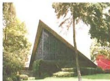
ヌエストラ・セニョラの礼拝堂 (1955)。スパンは対角線方向に各々25m、30m。きわめてシンプルで明快な単一のHPシェル。
