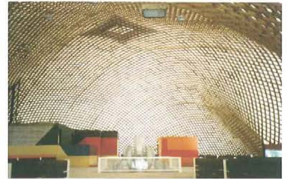
マンハイムの多目的ホール (1975)。地上で組まれた格子は中央部を押し上げられると、自然に曲ってドーム曲面を形成することができる。
