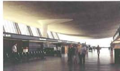
ダレス空港ターミナル (1962、ワシントン)。屋根を抜く支柱、傾斜させたガラス面。曲げモーメントの視覚的利用。設計のテーマは、重量吊屋根とモービルラウンジ。音響効果は抜群である。
