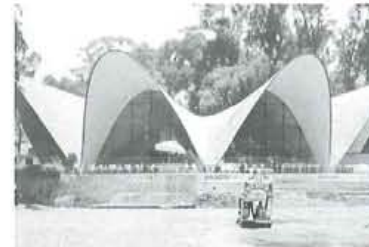
スパン30m、中心からはね出し先端まで21m、四つの鞍型交差シェルの相関。
