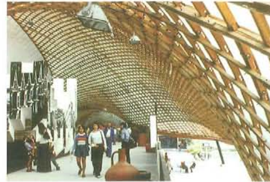
マンハイムの多目的ホール (1975)。地上で組まれた格子は中央部を押し上げられると、自然に曲ってドーム曲面を形成することができる。
