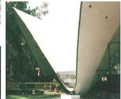
4cmのシェル厚は、足元で12cmに補強されている。
