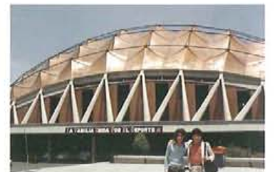
メキシコオリンピック・スポーツパレス (1968)。15年以上、HPシェルを追い続けたキャンデラが到達したひとつの結論は「RCシェルの限界は30m」であった。したがって、ここではスチールの立体トラスとHPルーフパネルの組合せを提案し、コンペを勝ちとった。世界で最も大きな鋼板葺屋根。
