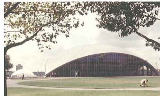
MIT (マサチューセッツ工科大学) クレスジ講堂 (1955)。3点支持されたRC球形シェル。脇には、小品ながら幻想的なチャペルが立つ。
