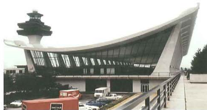
ダレス空港ターミナル (1962、ワシントン)。屋根を抜く支柱、傾斜させたガラス面。曲げモーメントの視覚的利用。設計のテーマは、重量吊屋根とモービルラウンジ。音響効果は抜群である。
