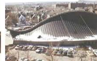
1本アーチの安定化のための補強ケーブルが見える。
