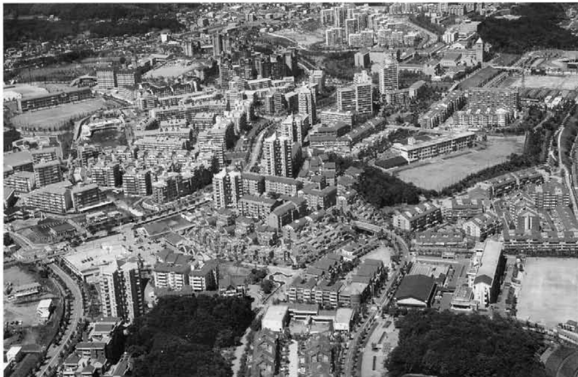
図1-1 多摩ニュータウンの全景/1971年第1次入居(諏訪 永山)以来、30余年が経過。現在約3,000haに17万人余りが住む
