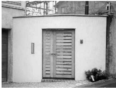
鉄筋コンクリート造の壁は従来から門や塀に多く用いられてきましたが、工事期間と施工規模、費用の面から、安価で施工の簡単なブロック積みがよく用いられてきました。ブロック積みでは構造的に問題のある、くりぬきやスリットを設けた意匠も、RC造の下地なら問題ありません。高めの壁や短い壁、曲線の形状、スリット、くりぬき窓等の意匠には適した構造といえます。打放し壁は、無機質で硬く冷たい印象を与えます。経年変化で汚れやすいので、何らかの仕上げを施したほうがよいでしょう。また打放し壁は洋風の建築に調和しますが、化粧仕上げをすることにより、和風にも調和します。
