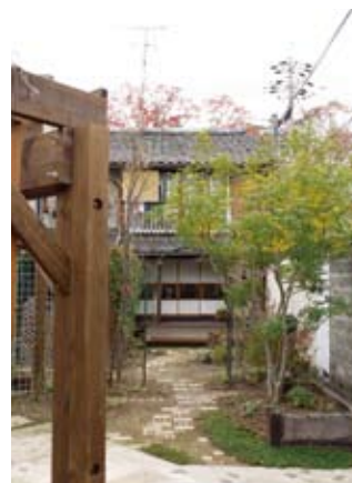
駐車場の床を仕上げ、トレリスとデッキの施工が終わり、植栽工事に入った段階。京都の町家独特の敷地形状である
