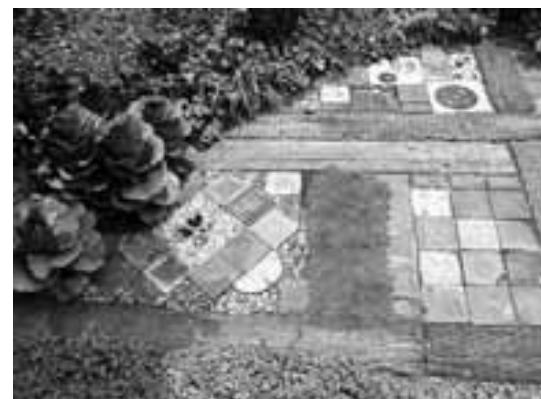
写真3-7-1 アンティークレンガ、枕木、芝、ガラス玉、丸鋸の歯など多様な素材で細かいディテールを施した駐車スペースの事例
