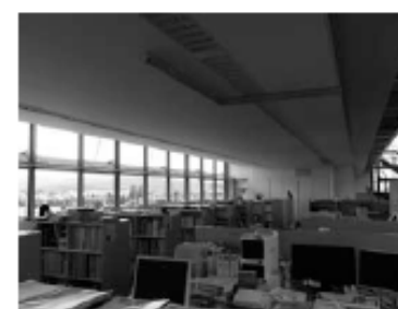
図9（左）ライトシェルフのある室内 両面採光と併用すると室内は電灯を点灯しなくても十分な明るさを確保できる。太陽高度が低くなる夕方や冬季は、使用者が室内のライトシェルフ下部にあるロールスクリーンを下ろし、明るさをほどよく調整できる
