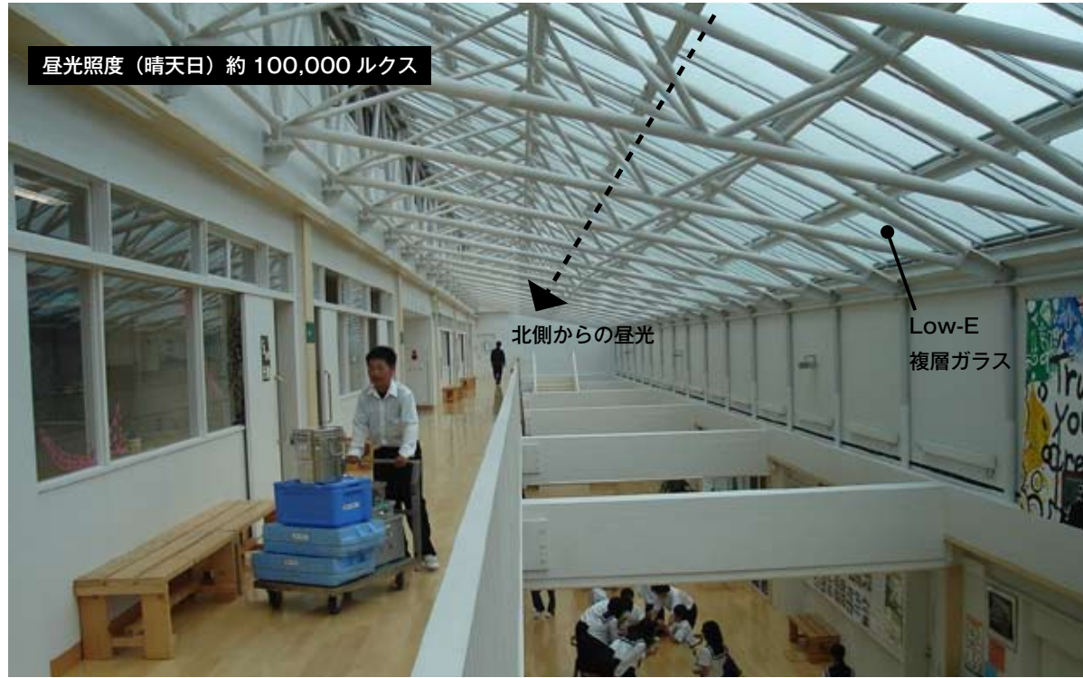
図1 昼光照明を行う中学校校舎の改修例 校舎の北側に設けられた「ひかりのみち」(写真右下)は廊下を兼ねるだけでなく、時には授業や集会、生徒らのコミュニティを創出する場として利用されている。吹抜け部分の梁は旧校舎時代のもの(「北海道寿都郡黒松内町立黒松内中学校」設計:アトリエアンプ)
