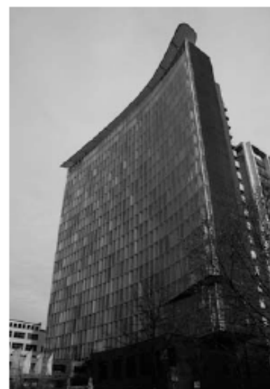
図11 使用者が調整できる可動ルーバー 西側に面するダブルスキン内部に日射遮へい用の縦ルーバーがある。使用者は光と熱の大きさを自由に調整できる（[GSW本社ビル] 設計：ザウアー・プルフ・ハットン、ドイツ・ベルリン）
