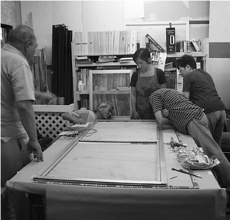
網戸の張り替えを行うスタッフと居住者
