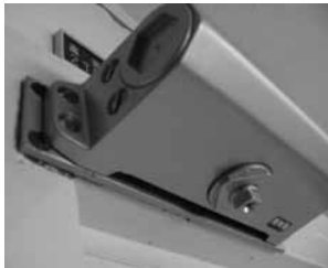
fig5-5 既存のものとビスピッチが違うため、アジャスターを必要とするドアクローザー
