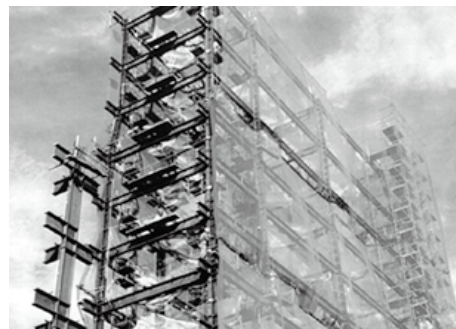
写真Ⅲ-9.3 中層建築における鉄骨建方の例
