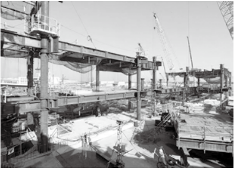
写真Ⅲ-9.1 鉄骨建方の状況
