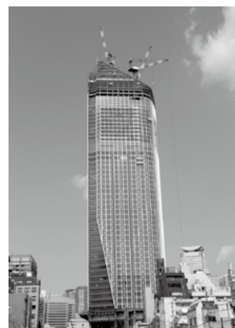
写真Ⅲ-9.4 超高層建築における鉄骨建方の例
