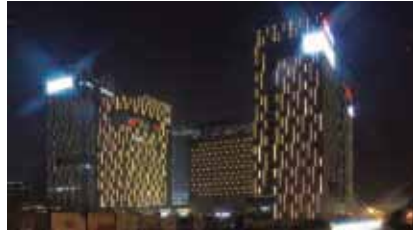
カーテンウォールのディテールに合わせてLEDを配置した高層ビル。点光源を用いることで、ファサードとの距離感やボリューム感が喪失され、ディテールの細かな立体感が演出されている。ファサードの迫力が都市に浮かび上がる(宇波東部新城)
