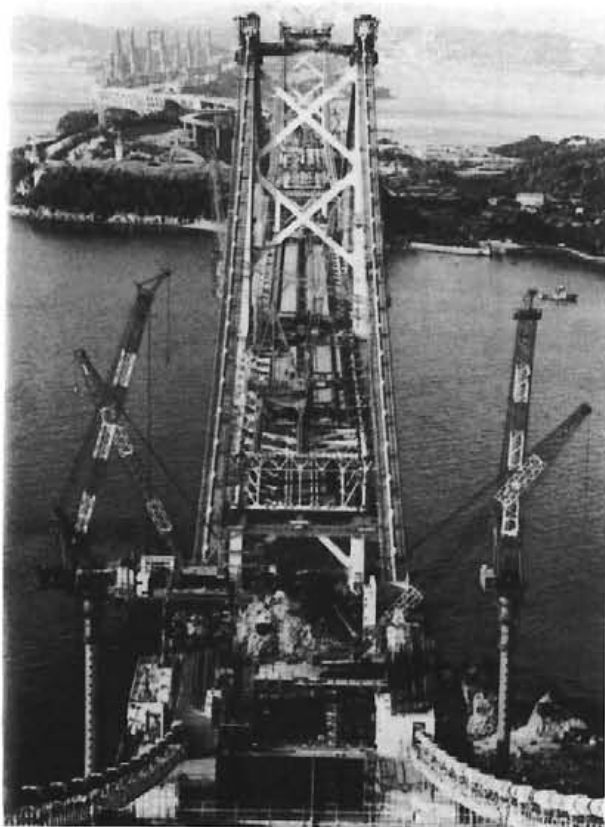
図 4.30 瀬戸大橋（土木学会提供）
