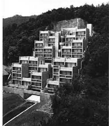
図2.25 地形なりの住戸積層(六甲の集合住宅/安藤忠雄建築研究所)
