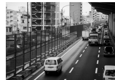
写真 3.2 幹線道路沿いの透明な遮音壁 (神戸)
