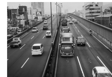
写真 3.3 高速道路に設置された遮音壁 (神戸)
