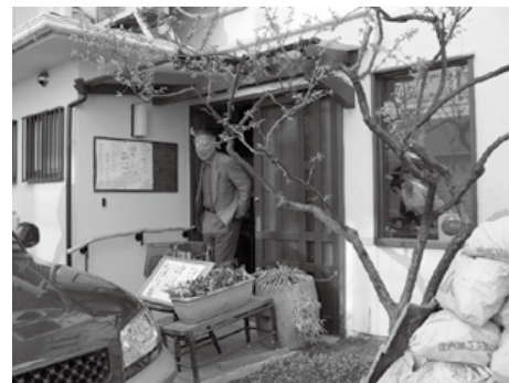
図3 図2の入口。もともとは掃き出し窓のある部屋だった。そこに入口を設け、土間に改修、トイレを付けた
