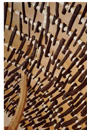
休憩室から茶室へ。炭のヴォールト天井
