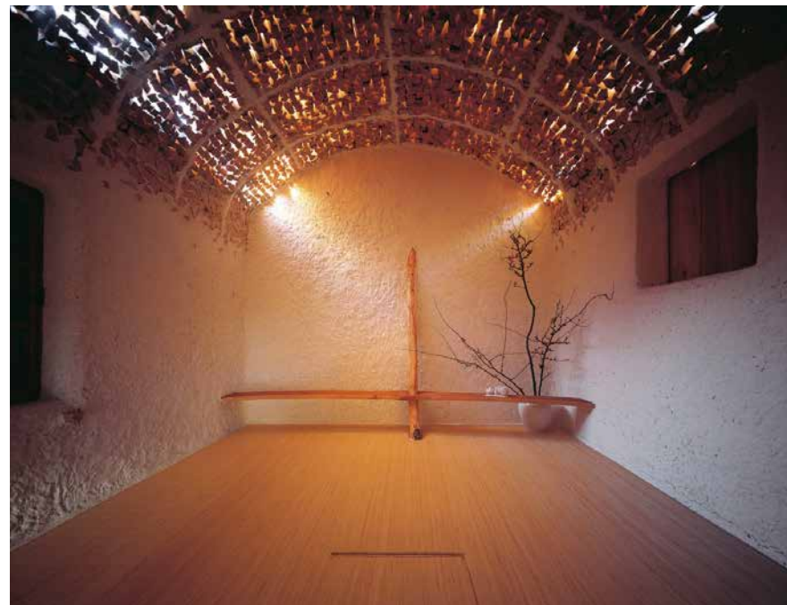
隠れ家から茶室へ。薪のヴォールト天井
