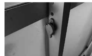
写真7 旧サッシのクレセント錠
