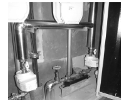
写真5 各戸の量水器と減圧弁(事例3)
