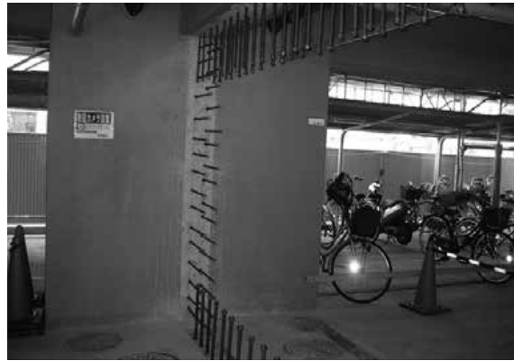
写真11 駐車場耐震壁設置のためのケミカルアンカー打ち
