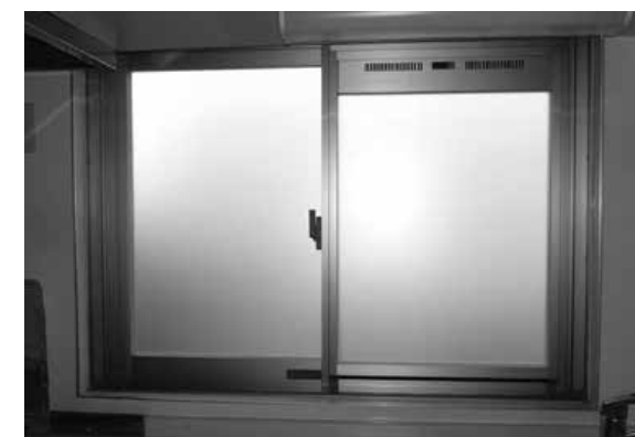
写真10 新サッシの換気ガラリ
