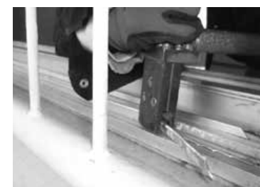
写真4 専用工具によるレール切断
