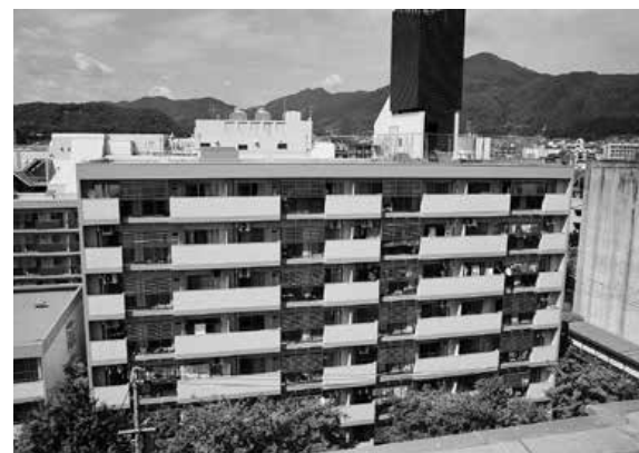
写真3 マンションの高層棟と高置水槽(事例2)
