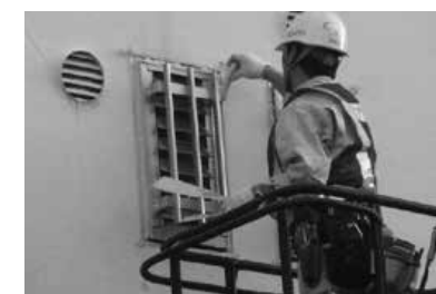
写真5 高所作業車による作業
