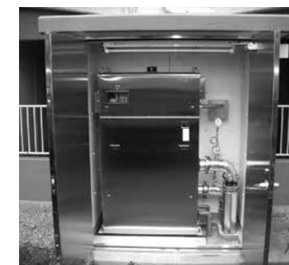
写真4 増圧ポンプ(事例3)
