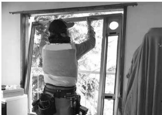
写真2 既存窓枠の上に新規枠を取付け
