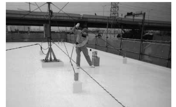
写真2 遮熱塗料を塗布させ完成
