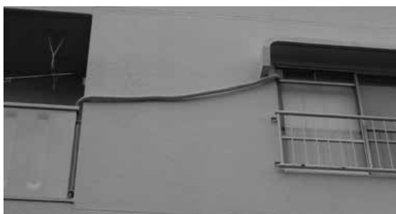
写真3 冷媒管の露出配管
