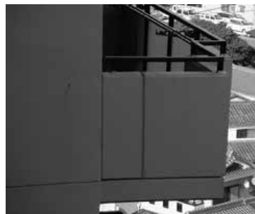
写真1 先端部が下がったバルコニー床の例
