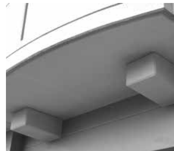
写真3 小梁で補強されたバルコニーの上げ裏
