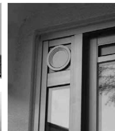
写真6 冷媒配管用パネルに設けたFIX窓の穴
