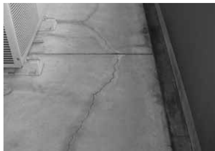
写真2 バルコニー壁と並行して走る連続したきれつの例
