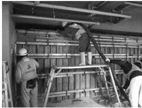
写真12 同上コンクリート打設
