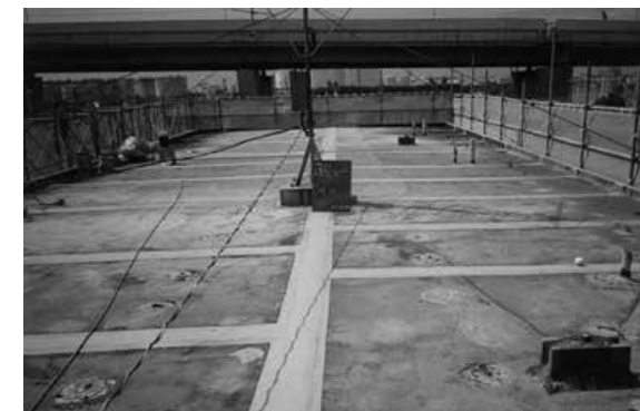
写真1 築25年ごろの屋上の状態(事例1)
