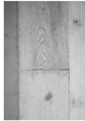
写真Ⅲ-7.2 板目が転写された打放しコンクリートの表面
