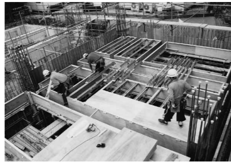
写真Ⅲ-7.5 鋼製仮設梁の使用状況
