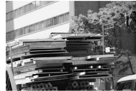
写真Ⅲ-7.3 枠組パネルの運搬状況
