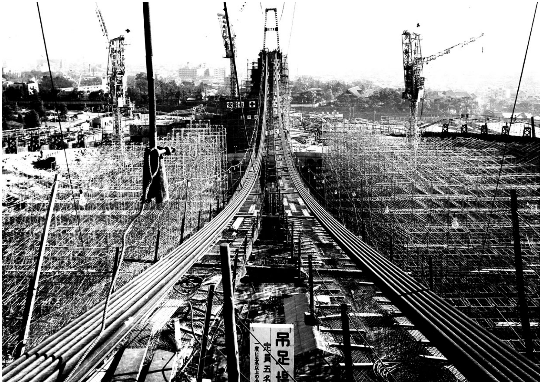
[8-9] メインケーブルの張渡し
