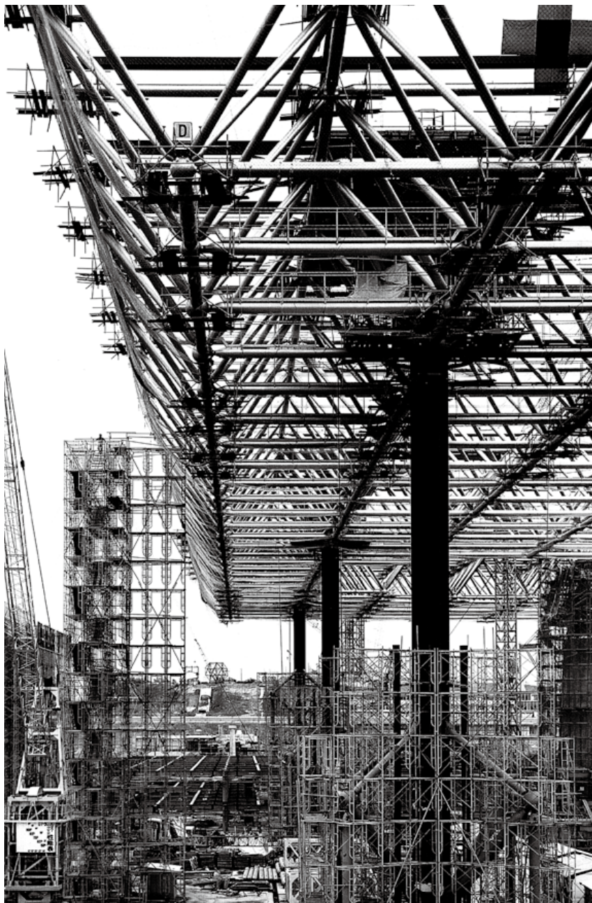
[10-10] リフトアップと主柱の補剛
