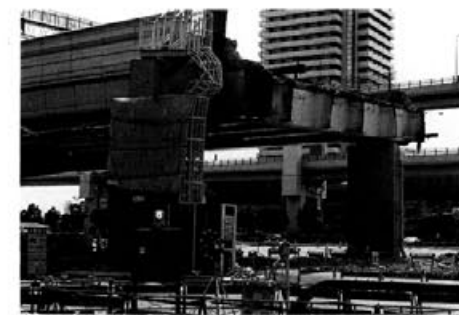
寸断された阪神高速道路。全線にわたって使用不能であり、抜本的な再建が必要である
