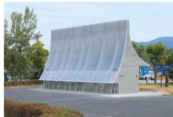
小豆島・草壁港に建つ公共トイレ。衛生機器を支持し、配管を納めるライニングや、それらを仕切るブース壁等、通常二次部材で処理される要素を構造体に置き換えることで、空間の要素はRC躯体と白い衛生機器のコントラストのみとなっている。コンクリートは、小豆島産花崗岩を粗骨材とし、小叩きや研ぎ出しこそといった技法により、石の表情が建物表面にあらわれる。頂点で接するRCスラブとETFE膜は、南北に枝分かれし、それぞれ、人、配管のための軒下空間を生む。南側のRCスラブは直射日光を遮るとともに、それ自体が暖められることで発生する上昇気流による、自然換気の効果を期待した。北側のETFE膜は内側がフロスト加工されており、利用者のプライバシーを確保しながら、日中は室内を明るい拡散光で満たす。また夜間は小叩きされたRC面を照らすLED照明によって、建物自体が港に置かれた照明器具となる。半透明の膜は、対象をぎりぎりまで近接させると、その映像を透過する性質がある。建物上部で小叩きしたRC面を膜面10mmにまで近接させることで、入港したフェリーに、高く伸びた小豆島石の矩形が正対する。
