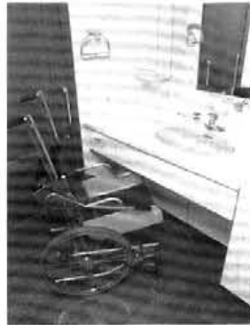
②洗面室 洗面台は車いすに座ったままで使え、ひざや車いすがあたらない
