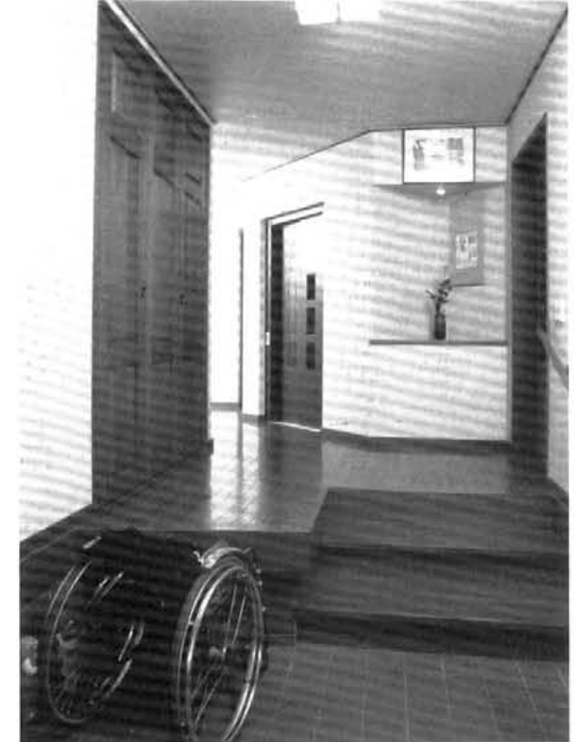
⑦玄関 長女が、室外用の車いすからの移乗が楽なように、玄関ホールの高さを車いすの座面に合わせている。右側には祖母のために手すり式台がもうけられている
