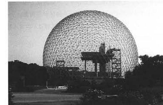
図3-20 モントリオール万国博覧会アメリカ館／設計：B.フラー、1967年。球と直線で構成するジオデシックドーム
