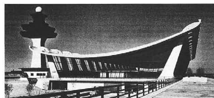
図7-6 ダレス国際空港ターミナルビル/設計: E. サリーネン、構造: アンマン&ウィットニー、1962年
