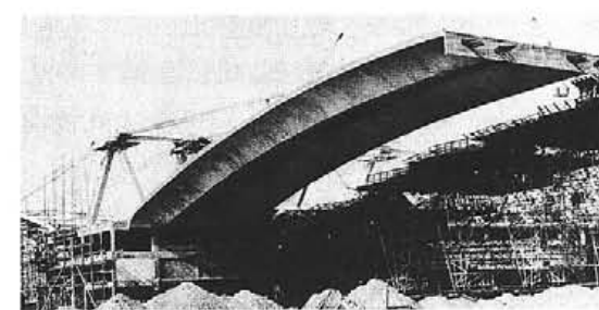
図7-10 フランクフルトのルフトハンザ格納庫/設計: O. エイベル、構造: H. ベッカー、1959年
