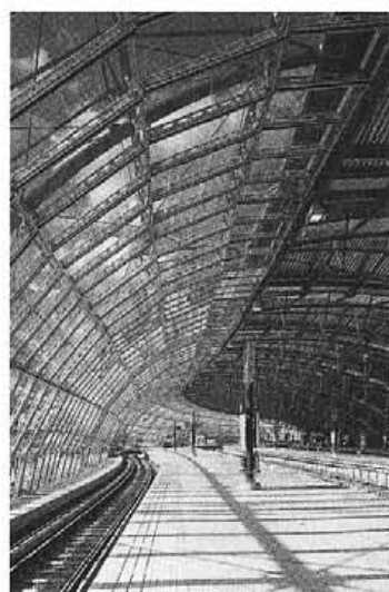
図1-19 ウォータールー・インターナショナル・ターミナル／設計：N.グリムショウ、構造：A.ハント、1993年。非対称の3ヒンジ弓形張弦アーチトラス。断面図の上の図は曲げモーメントを図化したもので、下の屋根断面図と比較すると圧縮材と引張り材との関係を忠実に形態に置き直していることがわかる。圧縮材は座屈の問題があるので相応に大きな部材になる。そのためそこに屋根材を置き、引張り側にはその性質を疎外しないように純粋な形態を保持している
