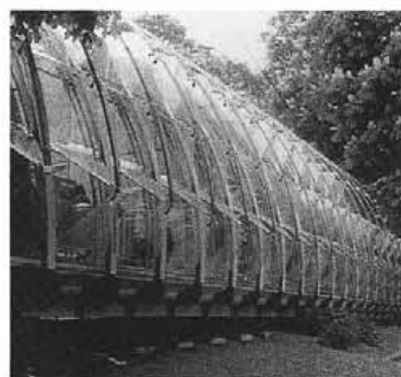
図1-17 IBM移動パビリオン／設計：R.ピアノ、構造：P.ライス、1986年。幅48m、高さ6m、奥行48m、34本のアーチで構成される。アーチはポリカーボネート製の6個のピラミッド形のエレメントからなり、集成材とアルミダイキャストで接続されている
