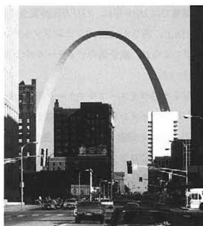
図1-16 ジェファソン・メモリアルアーチ／設計：E.サーリネン、構造：F.シヴィラッド、1964年。スパン、高さとも200m。サーリネンは完成を見ることもなく他界し、仕事はケヴィン・ローチ、ジョン・ディンケルが引き継いだ。西部開拓使の入り口。通称ゲートウェイアーチ
