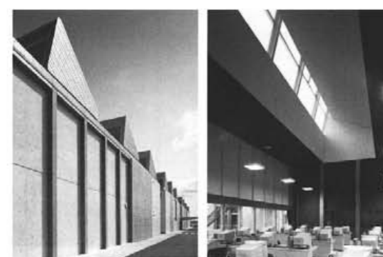
図7-6-7 宮城県立迫桜高等学校 (ルーバー、自然換気、太陽電池。写真撮影：和木通)
