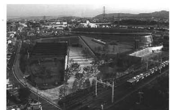
図7-6-8 西京極アクアアリーナ (ルーバー、屋上緑化、自然換気。写真提供：環境デザイン研究所)
