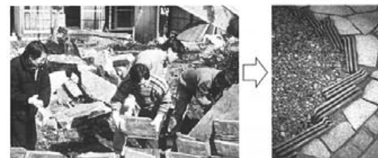
建替え住宅で、従前の瓦を外構に再利用したり、井戸や樹木を保存して再利用している。
