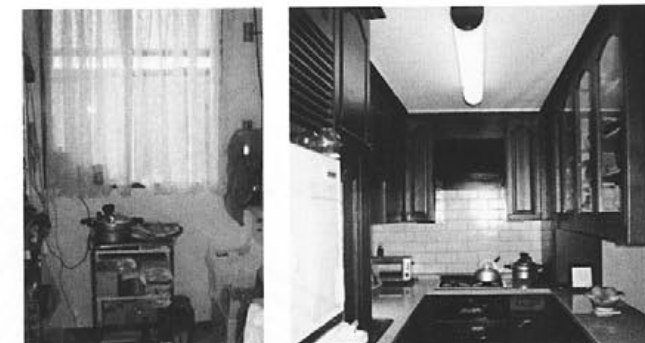
c) 窓をつぶしてコンロを設置（左が改装前）
