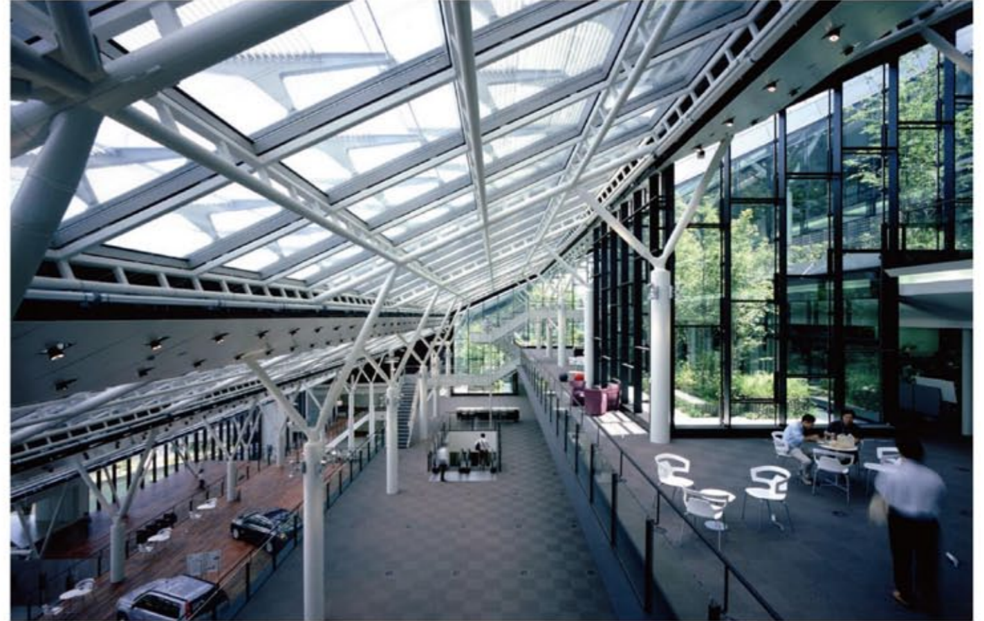
日産先進技術開発センター NISSAN ADVANCED TECHNOLOGY CENTER
