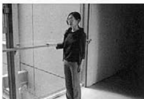
図9 手すりの解釈を誤って高く設定してしまった例
