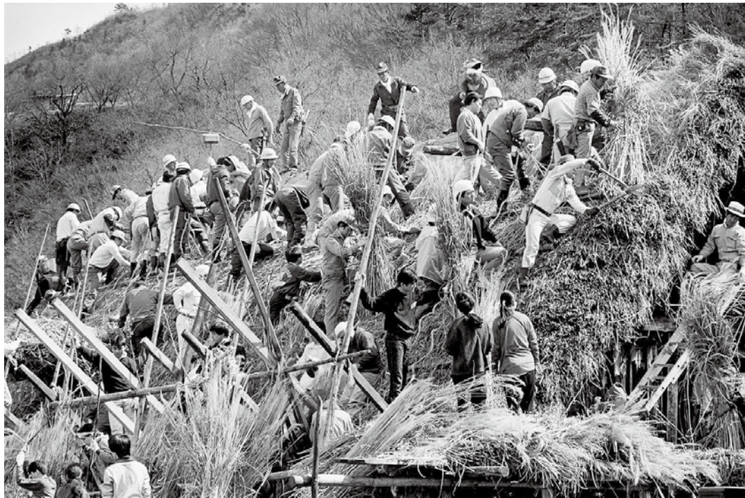
写真1 白川郷の合掌造り民家における屋根の葺き替え作業。「結い」と呼ばれる作業で、屋根が葺き替えられていた
