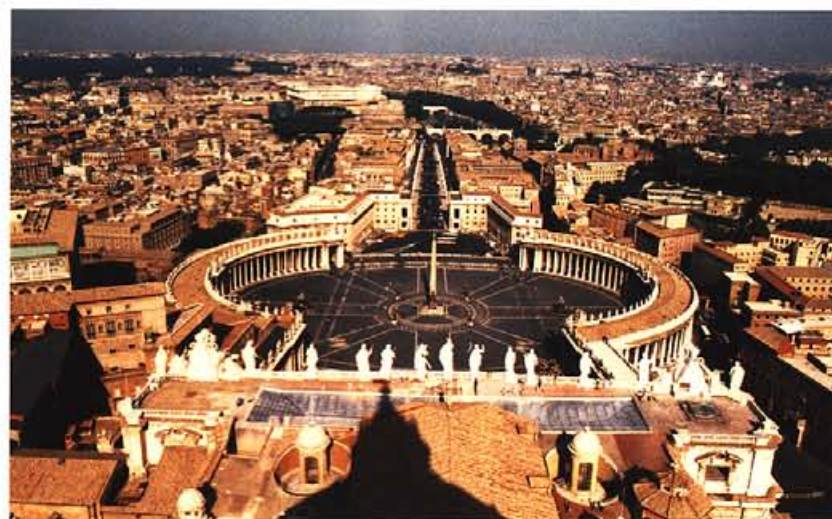
①サン・ピエトロ広場 (G.ベルニーニ、1656-67年、ローマ) 長径200m、短径165mの楕円形広場。周囲は高さ18.3mのトスカナ式円柱285本、角柱88本を4列に並べたコロネードで囲んでいる
