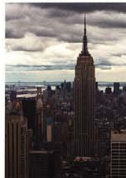
④エンパイア・ステイト・ビル (R.シュリーヴ+W.ラム+A.ハーモン、1931年、ニューヨーク) 102階、381m、斜線制限によるセットバック方式の典型的なデザインの高層ビル
