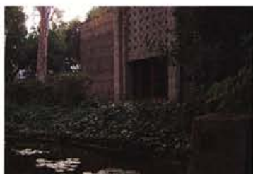
②ミラード邸 (F.L.ライト、1923年、カリフォルニア州、アメリカ) 透かし細工をほどこしたコンクリート・ブロックを壁面意匠に取り入れた建築。1920年代のライトは、質素で安価なコンクリート・ブロック製の住宅の開発に専心していた
