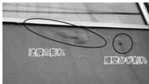
写真-1 塗膜が膨らみ、ひび割れも発生
