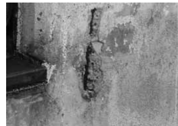
写真-2 露出した開口部の補強筋
