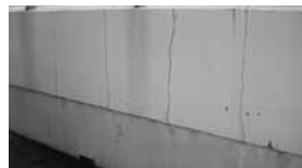
写真-3 屋上駐車場腰壁のひび割れ
