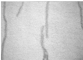
写真-2 美しくはないが、漏水は止まる
