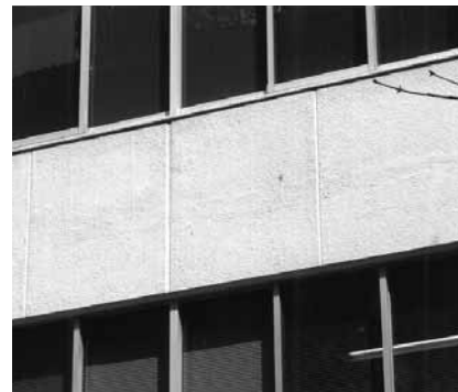
写真-4 1.3mピッチに目地を入れた腰壁は、40年を経ても健全で美観を保っている。
