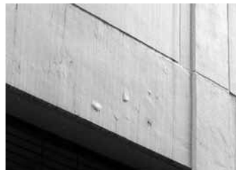
写真-2 防水型弾性塗料の膨れ
