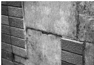
写真-1 下地処理をほとんど施していない
