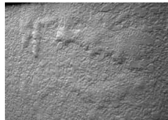
写真-3 アクリルシリコン塗装の塗膜の浮き
