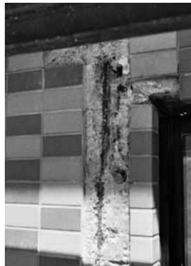
写真-1 タイルが剥落、壁筋が露出
