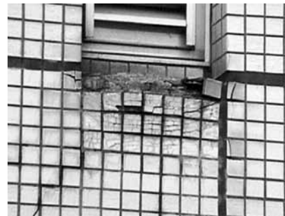
写真-2 窓台タイルの破損
