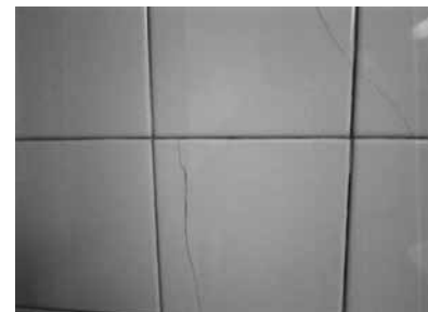
写真-2 タイルの割れ
