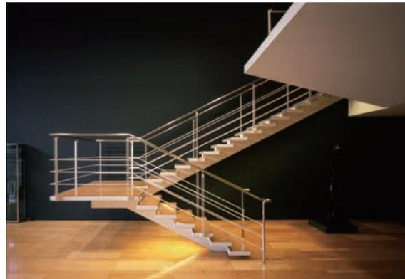
世界トップクラスの先端技術とシェアを誇るオーディオメーカー社屋のエントランスホール吹抜の鉄骨階段。リズムカルに連続する段板の浮遊感を強調するため、2枚のさらプレート可能な限り中央に寄せ、そのプレートの間に既製のシームレスライン照明を直付けしている。メンテナンスの容易さを図るとともに、上方(踏面側)に対してはフットライト、下方(段裏側)に対しては建築化照明としての役割をもたせ、階段そのものを発光する彫刻的なオブジェのように見せている。また、手摺は溶接痕が直接見えないように配慮しながら最小断面の線材を巧みに組み合わせており、階段の繊細さと軽やかさを一層際立たせている。アクロバティックな手管に走らず、モノのあり方を素直に、かつ厳しく追及することで生まれる「素(す)」のディテールの好例である。
