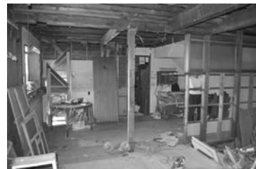
図1 工事着手直後。外壁はそのままに内部から改修
