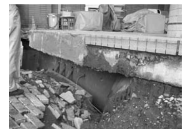
図7 建物導入部の配管
