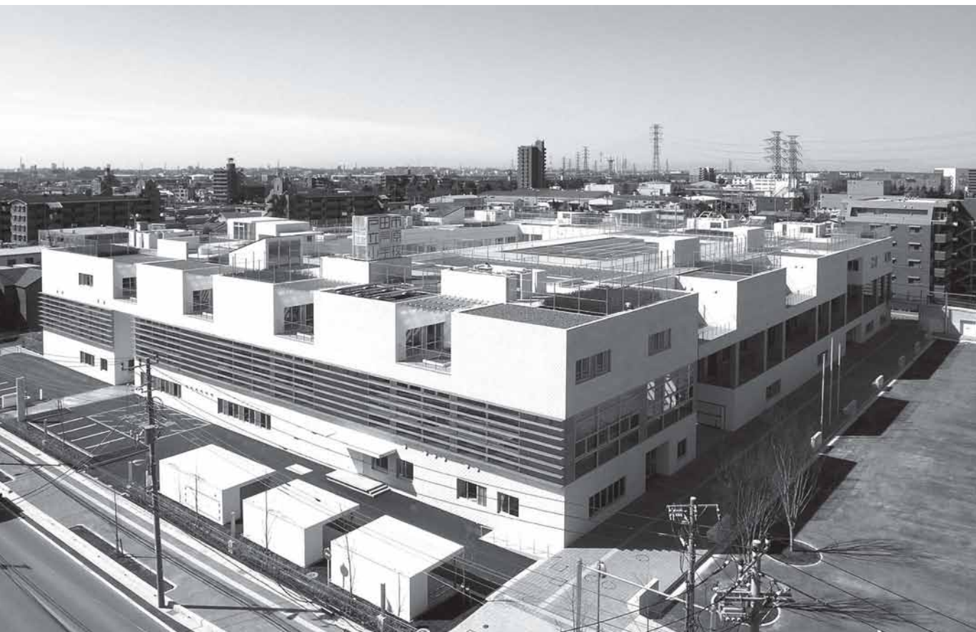
北東からの全景
