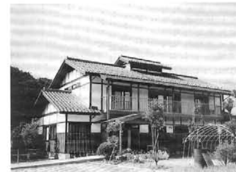
図 3-5-26 越し屋根による通風促進
