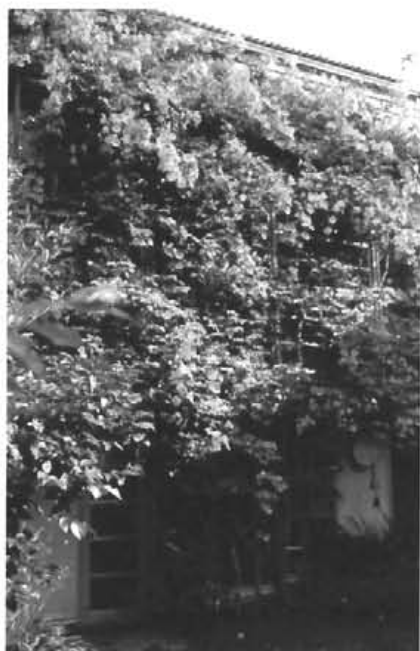
写真2-7-7 蔦植物による日射遮蔽 冬枯れて日射を取り入れ、夏繁茂して遮蔽する植物は、自動制御の日射制御装置でもある。(つくば)
