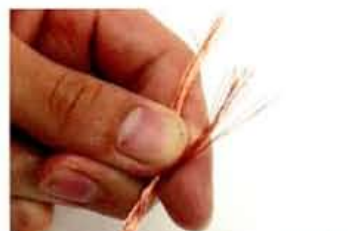
② 皮を剥いて2つ折りにし、根の方をより合わせる。芯線が多すぎる場合には、適当に減らす
