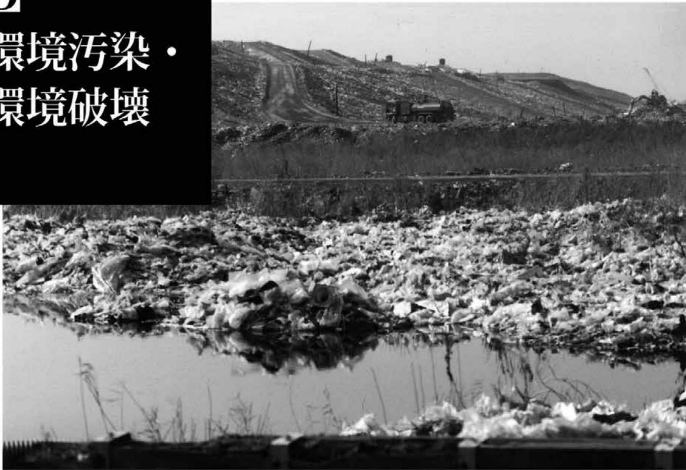
写真は、1990年代の東京港中央防波堤内側のゴミ埋立処分場の様子である。ゴミと土を交互に積み上げ、標高30m(当時)の島が出現した。当時プラスチック系ゴミは、ダイオキシン発生問題もあって不燃ゴミとしてそのまま埋め立てられていた。また可燃ゴミも焼却能力が追いつかず、一部はそのまま埋め立てられていたので、強烈な臭いとともに、残飯を狙って海鳥たちが大量に群がっていた。さらに、ゴミが土中で分解されるにしたがって、大量のメタン(可燃性・温
