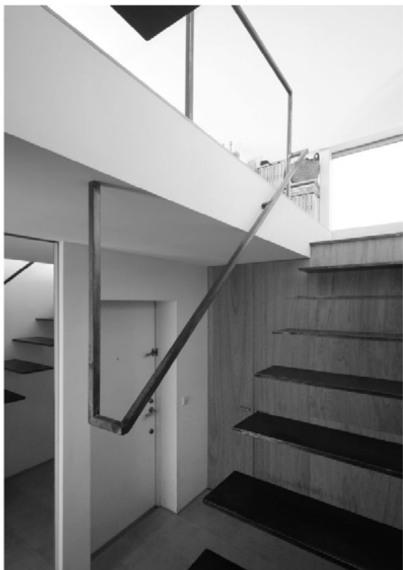
エントランスのタタキをまたぐように設置された階段
