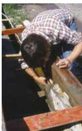
写3 タリアセン・ウエスト独特の石打ち込みコンクリート作業。新人はまず施工から教わる。
