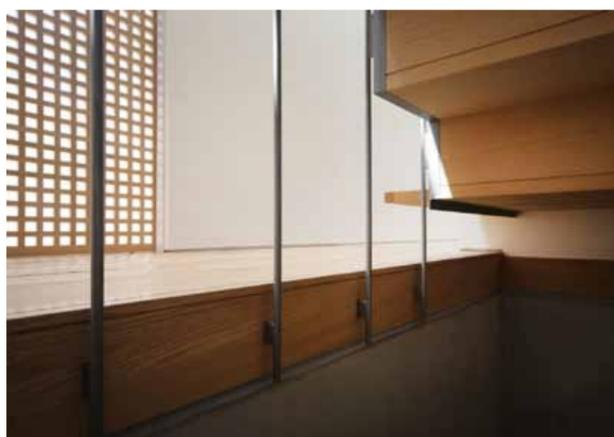
1階がRC造、2、3階が木造の混構造の住宅で、それに伴い1階から2階への階段はRC、2階から3階への階段は鉄骨造となっている。RC部分は打放し仕上げのさりげない表現であるが、段鼻にナラ材のノンスリップを逃ががほぼゼロの状態に埋め込んでいる精度は、施工時の気遣いを感じさせる。またコンクリート部分も一発仕上げによるもので、補修をしないことへのこだわりが見てとれる。
