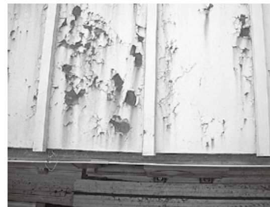
写真1 瓦棒葺き屋根の錆
