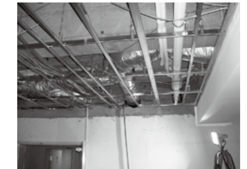
写真2 空調ダクトや設備配管が設置されている天井裏（重量物は直接躯体から支持）
