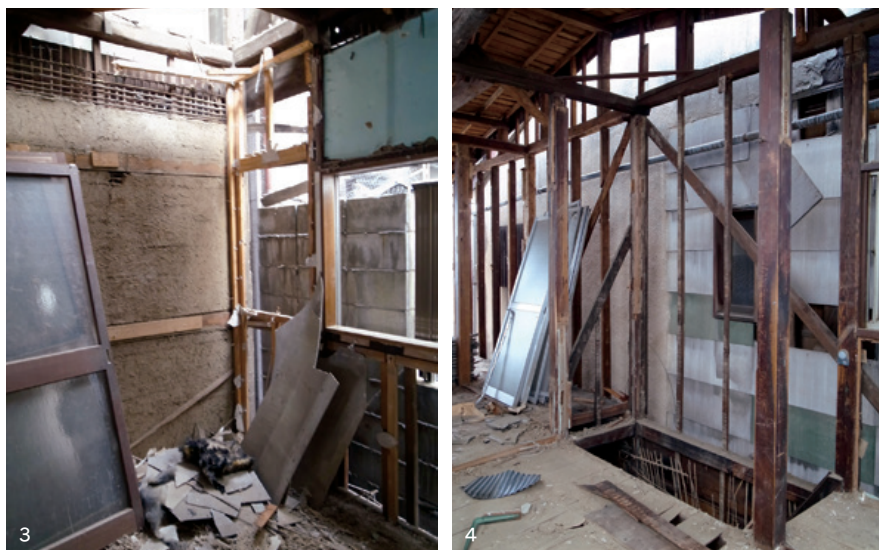
3 解体して見えてくる外壁の左官や下地の様子。さらに手で除去して現れた柱や梁 4 柱と梁にするスケルトンリフォーム。柱と梁があらわになった状態まで解体して構造をチェックしていく
