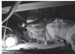
床下にはカバーオールなどを着用してヘッドライトを点けて入る。身動きがとりにくいので、用具をまとめて持ち込む
