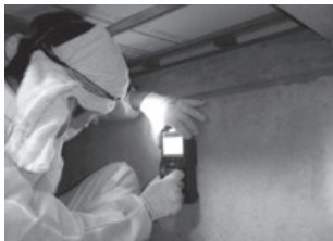
基礎がある場合は鉄筋のチェックをする。図面があってもひとつとおり見ておく
