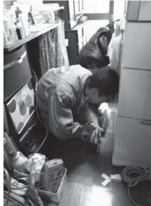
床下点検口や床下収納がない場合、工務店の力を借りて床下への進入路を設ける必要がある。あらかじめリフォームで壊す部位などに開口を設ける
