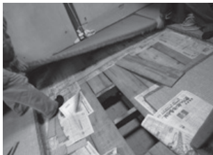
2階床下などは畳を上げて荒板を外して調査する。くれぐれも踏み抜かないように注意
