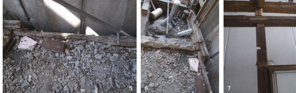
5 解体すると土台らしきものが現れた。しかし形はほとんど朽ちて残っておらず、基礎と共に改めてつくる必要がある 6 浴室まわりの木材も溶けたように腐朽しており、長い時間の中で水シミが床下に回っていたようだ 7 サッシの再利用で残すことになった部位の柱には、エアコンスリーブの穴が。
