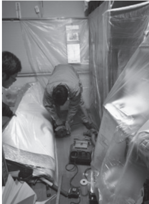
クライアントが住んでいる状況で調査をするので、養生はしっかりと行う
