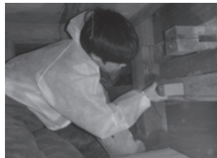
床下の木材の含水率や水平、金物も見る。床下の含水率が高く、蟻害がある場合が多い
