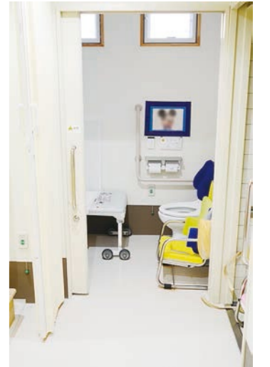
図9 奥と左に便房あり。右はシャワー室。奥の便房は車いすでは接近しづらく、介助者が2人体制の場合はさらに狭くなり介助が難しい(さくら草特別支援学校)
